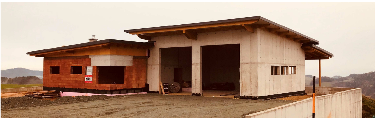
Foto Baustelle FF Haus Obereck – Stand 16.11.2020
